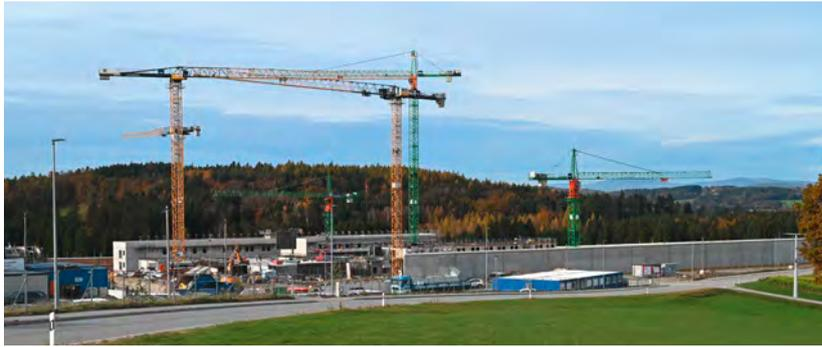
800 Meter Anstaltsmauer aus Fertigstahlbetonteilen umgeben die spätere Kombianstalt.
